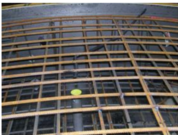
Рис. 12. Предварительно смонтированная инъекционная система в армокаркасе блока
