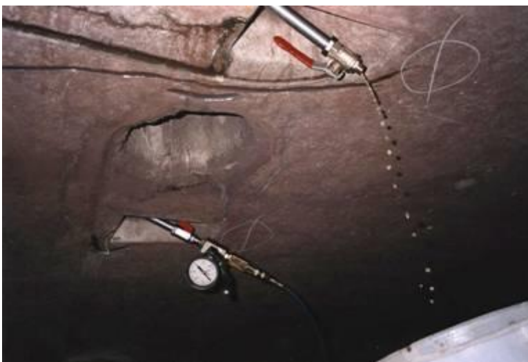
Рис. 9. Инъекция через монтажные отверстия
