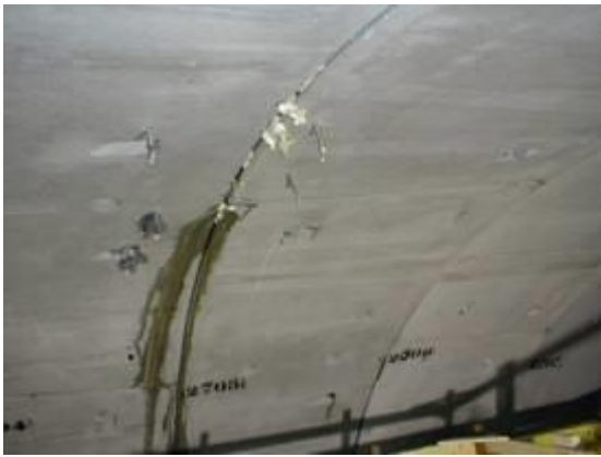
Рис. 4: Частичный выход пены из стыков тубингов
